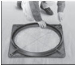
①型枠にマンホール受け枠の位置を墨出します。
