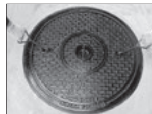
③作業終了後は、V型取手でマンホール鉄蓋を移動させて蓋をします。
