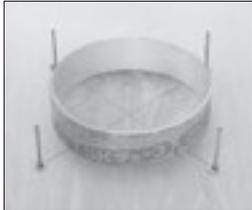
④スラブ厚に応じた紙管を置き、釘で数カ所固定します。
