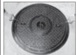
③作業終了後は、V型取手でマンホール鉄蓋を移動させて蓋をします。
