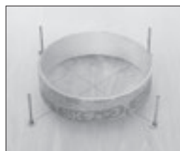
④スラブ厚に応じた紙管を置き、釘で数カ所固定します。
