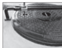
②六角ナットを締め、マンホール鉄蓋と枠の縁切りを行います。
