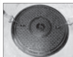
③作業終了後は、V型取手でマンホール鉄蓋を移動させて蓋をします。
