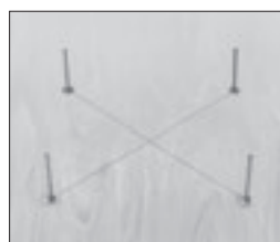
③固定ブラケットにボルトナットを取付けし、レベルを調整します。
